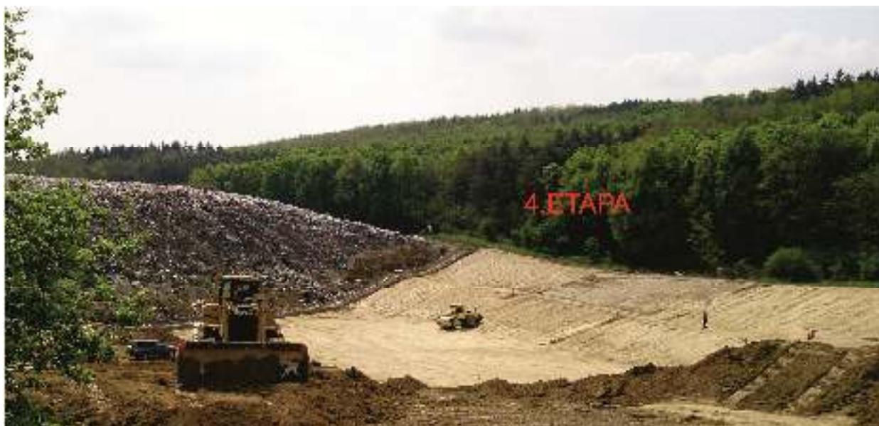
Obr.3 – Zemné práce pre výstavbu 3.etapy – pohľad zo severu
